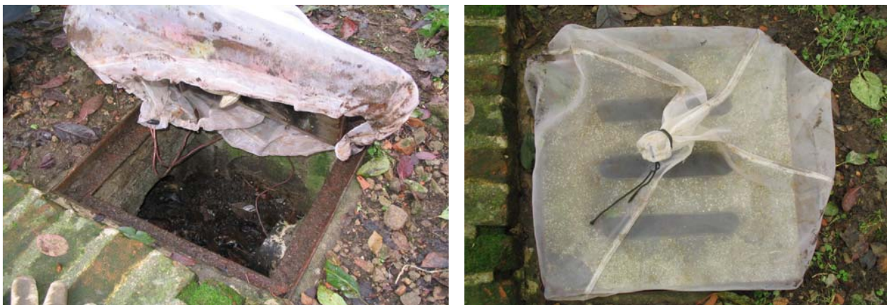
Fig. 8.9 Copertura del tombino stradale
