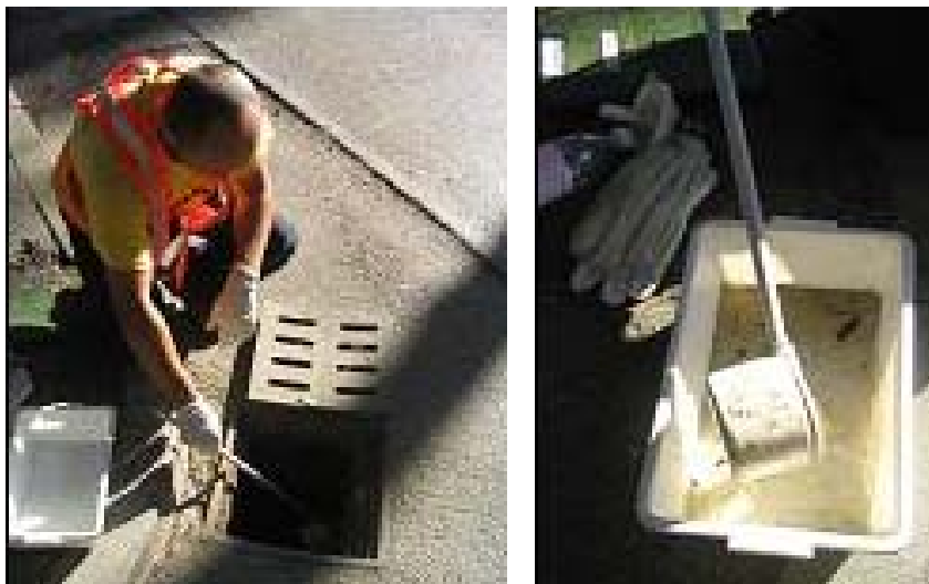
Fig. 9.1 – Fasi del controllo delle caditoie interessate dalla sperimentazione
